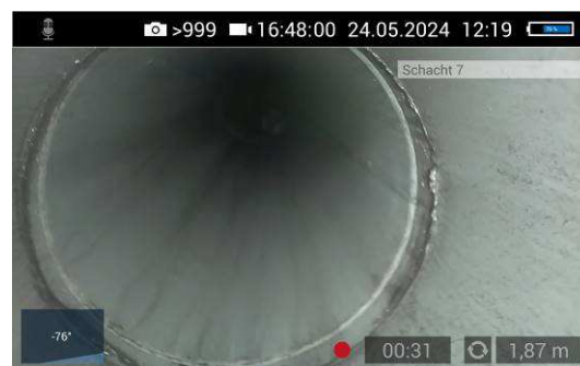
Twijfelachtige verbinding in CLV systeem 7
