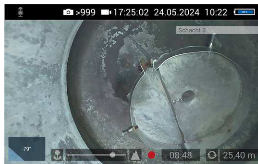
Losliggende afsluiting CLV systeem 3
